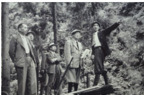
砂防工事現場視察
